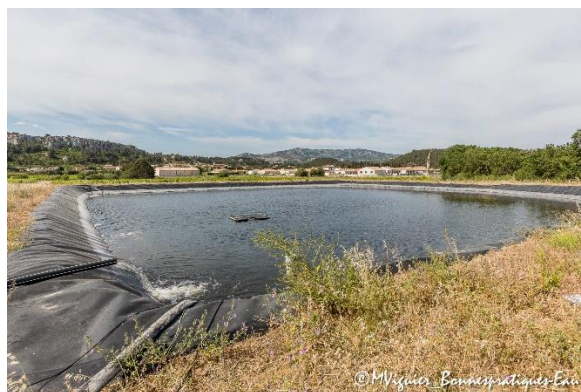
Figure 1 : Bassin de stockage des EUT, Roquefort-des-Corbières (2021, Bonnespratiques-eau)
