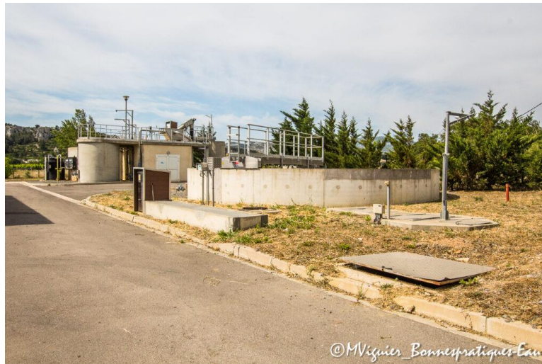
Figure 4 : Station d'épuration de Roquefort des Corbières (2021, Bonnespratiques-eau).
