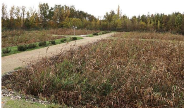
Figure 1 : Filtres plantés de roseaux, unité de traitement de Nègrepelisse.
