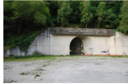
Tunnel de la Station (inachevée) de Transfert d'Énergie par Pompage de Redemat (19)
