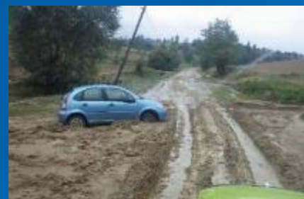
Perte capital sol (coulée de boue)
