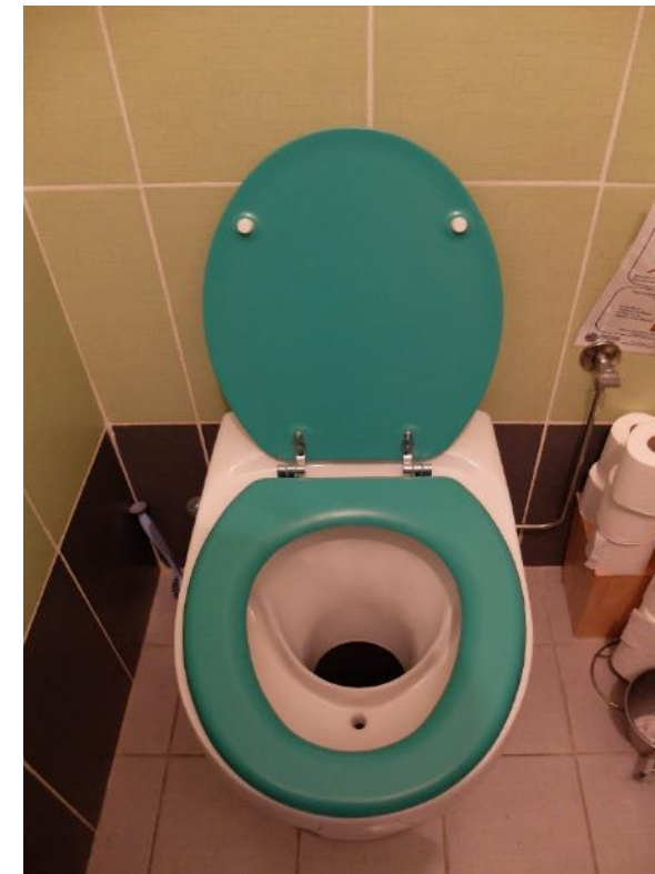
Toilettes sèches à séparation d'urine ; composteur intégré Composteur au même niveau (à gauche - Ecodomeo) ou composteur en sous-sol (à droite Clivus)
