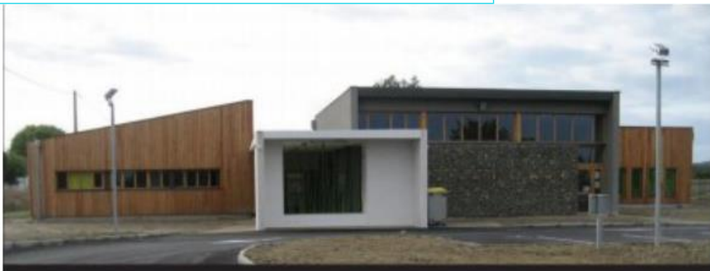
Vue du bâtiment de l'école.
